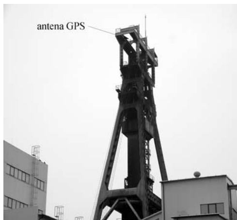
Rys. 3. Antena GPS na szczycie wieży szybu S 1.3 Figure 3 The GPS antenna on top of the tower shaft S 1.3
